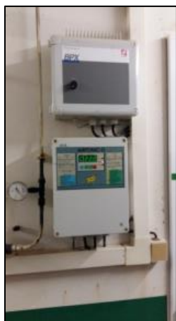
Figure 37: Boitier Airtronic D surmonté de son boitier de régulation
